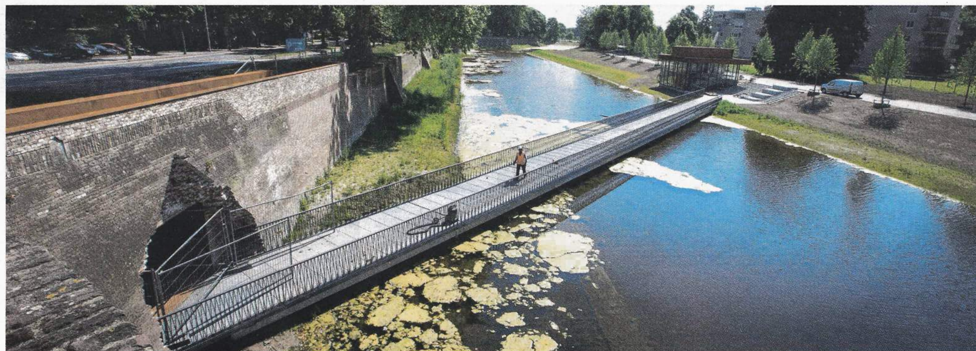
▲ De nieuwe parkeergarage Sint-Jan is deels in de oude vestingmuren gerealiseerd. Bezoekers lopen over een brug door een gat in de vestingmuur van en naar de historische Bossche binnenstad. FOTO SANDRA PEERENBOOM
