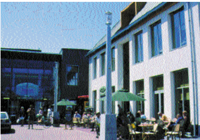
lichtmast met hardstenen sokkel op pleinen
